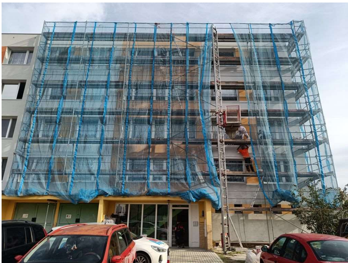
Foto č. 4: Průběh zateplování bytového domu
