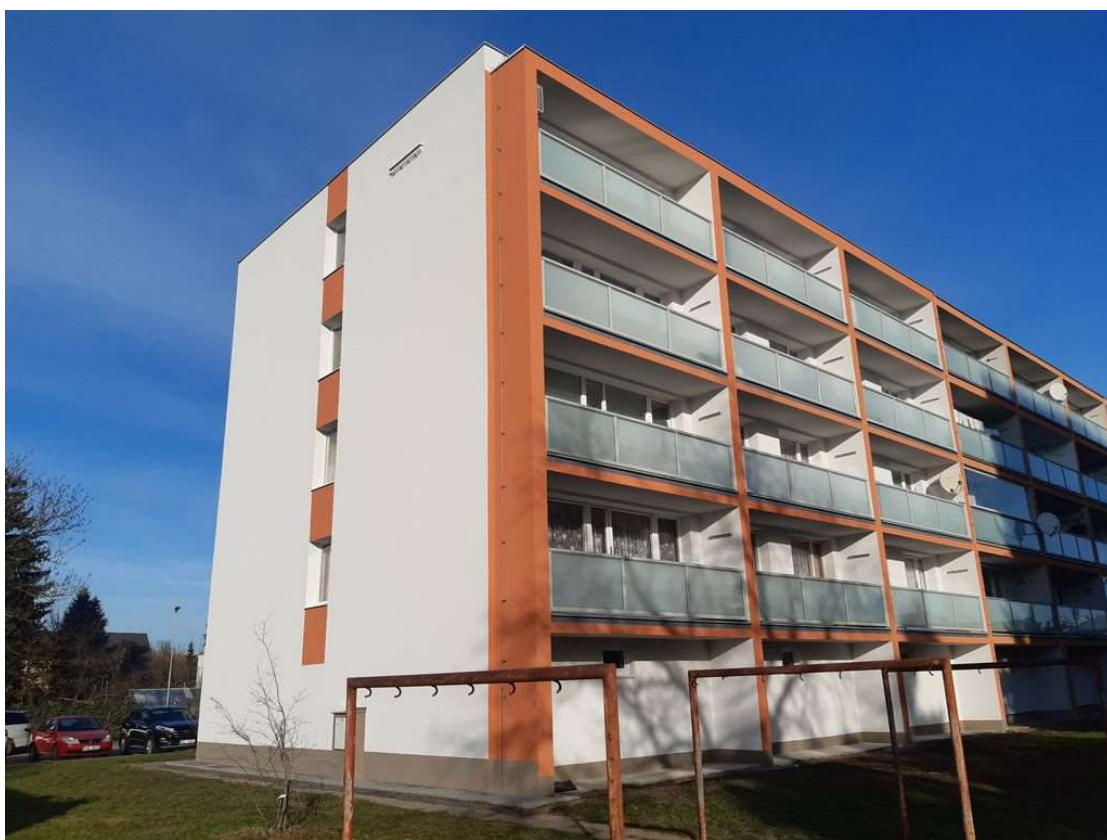
Foto č. 5: Dokončená revitalizace fasády
